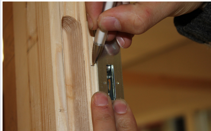
Afb. 9 Haaksparing gelijk aan afgetekende Sluitplaat
